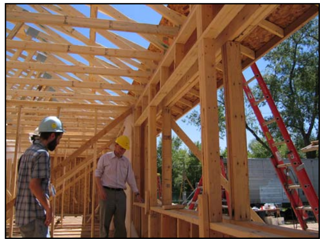
Fig. 3: Double stud wall framing
